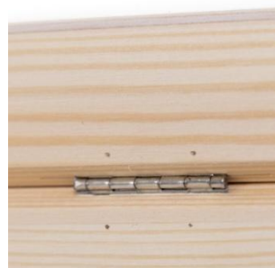
◀ Gesteckte Scharniere doppelt genagelt ▶
